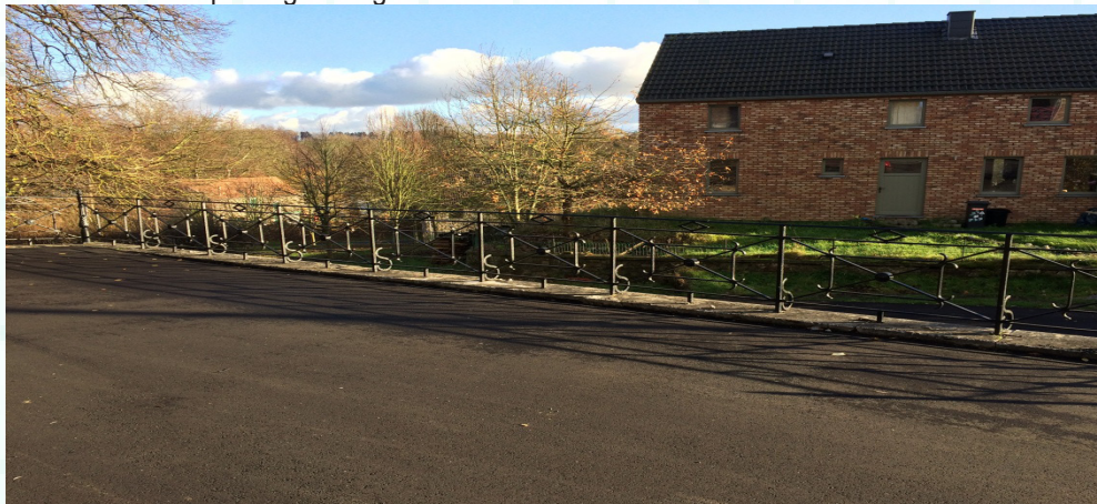
des deux versants du pont de la rue des Eglises à Hailot
